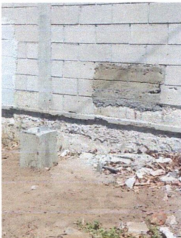
Foto 3: Reparación de muros de contención
