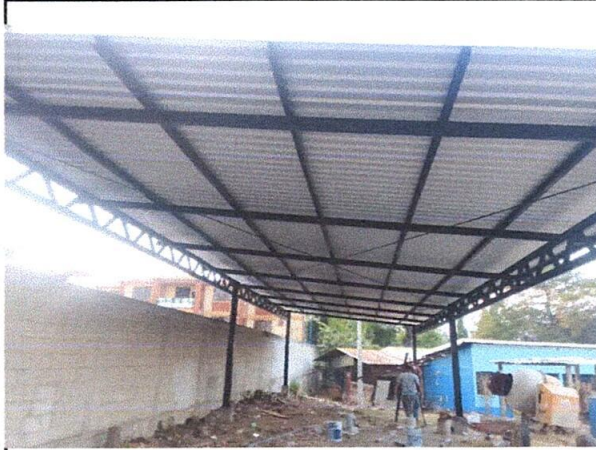
Foto 1: Cubierta de lámina.
