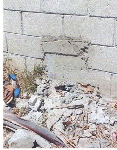
Foto 4: Reparación de muros de contención
