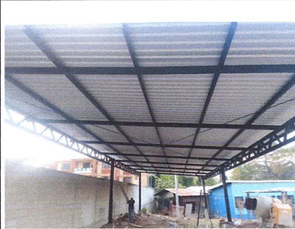
Foto 2: Estructura de techo.
